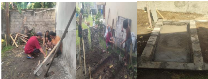
Gambar 4. Pembuatan dasar bangunan oven
